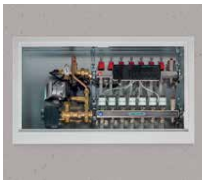
Vgradna omara za consko regulacijo Seltron ZCE 2
