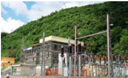
Slika 2: Zaprto stikališče HE Plave med obnovo (vir: Čebtron, R.)
