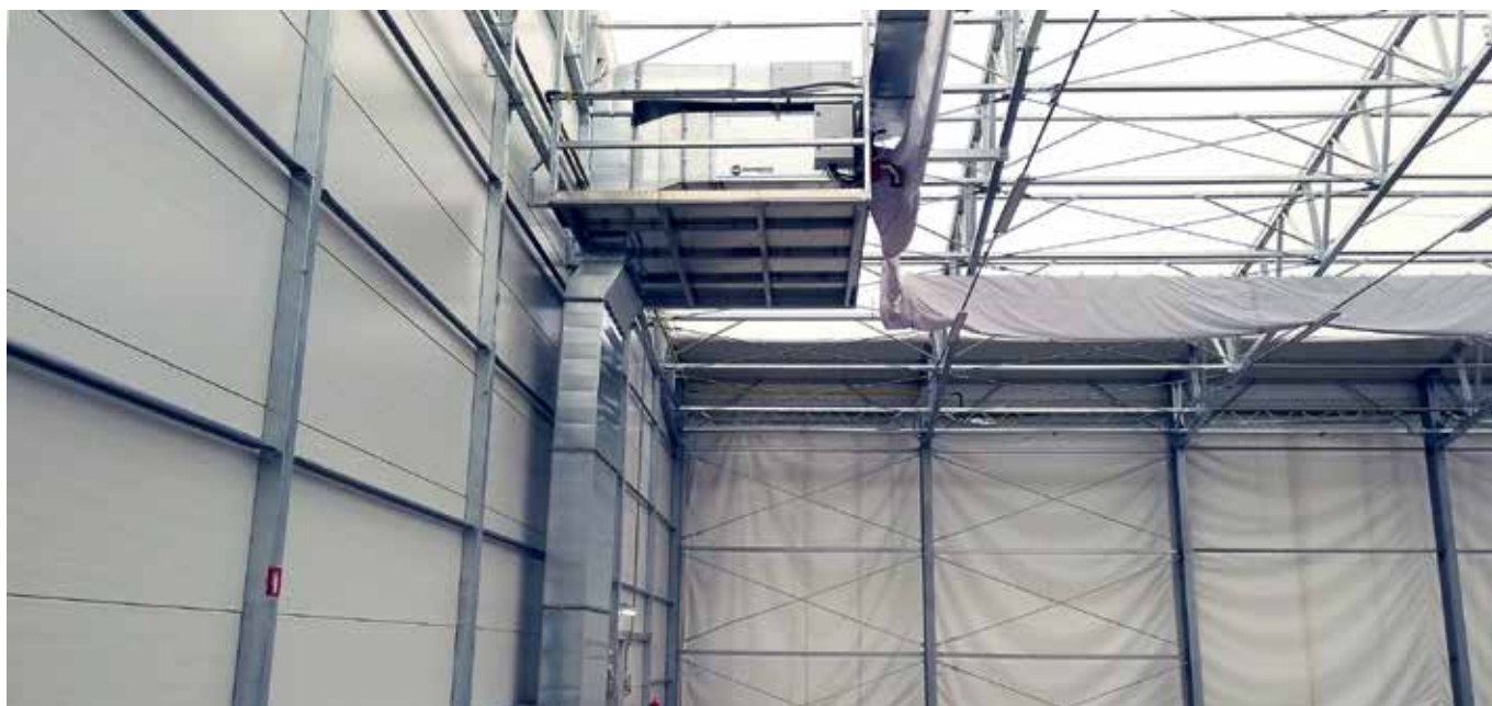
Slika 3: Primarno ogrevanje s pomočjo BIEMMEDUE plinskih grelnikov.
