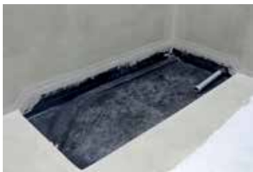
Slika 6: Vzorno izvedeno tesnjenje pod kadjo
