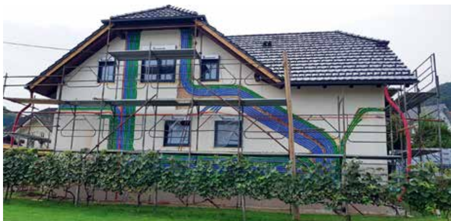
Prikaz izvedbe centralnega prezračevalnega sistema na obstoječem objektu
